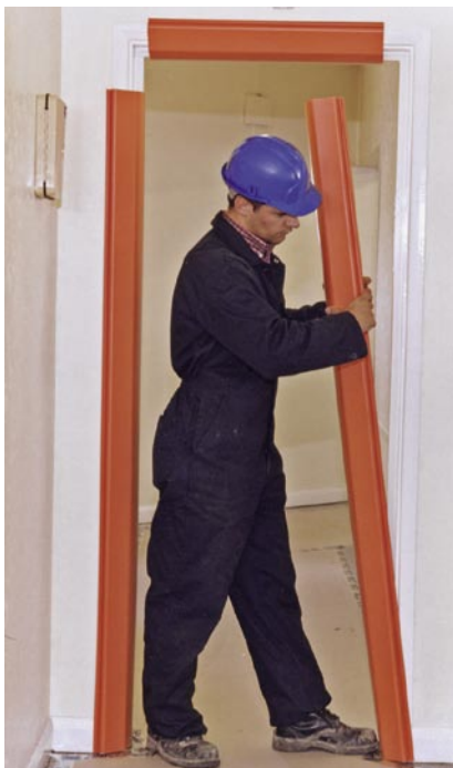
Statt zeitaufwendiges Abkleben mit Karton: Diese PVC-Schienen (zum Draufklicken) schützen die Türrahmen vor Beschädigungen
