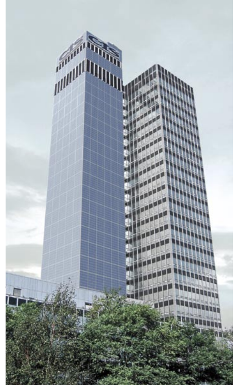
Fassadenintegrierte PV-Anlage: Der CIS-Tower in Manchester (GB) wurde von Sharp Solar realisiert und war zum Zeitpunkt der Einweihung die höchste PV-Fassade Europas
