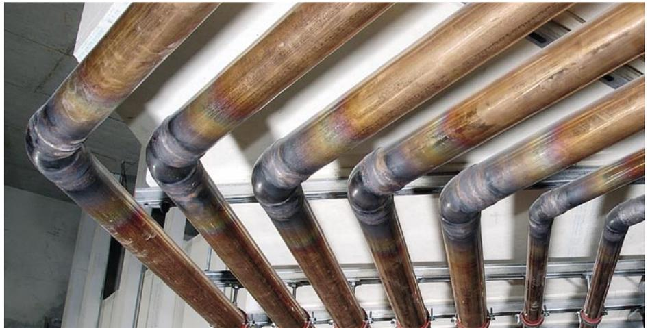
Für die Trinkwasserversorgung sind 10 500 lfdm Kupferrohr im Einsatz
