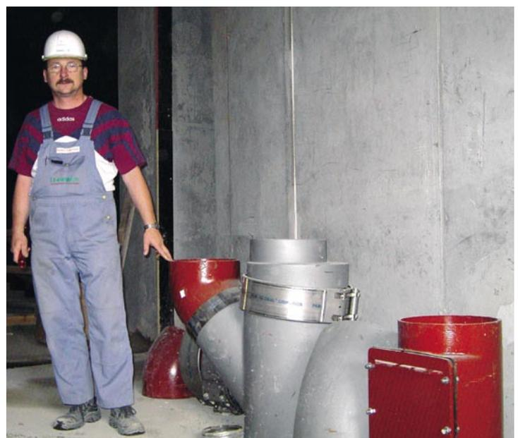
Obermonteur Karsten Engelmann vor gusseisernen Rohren und Formstücken, die je nach Einsatzbereich in SML oder KML ausgeführt sind
