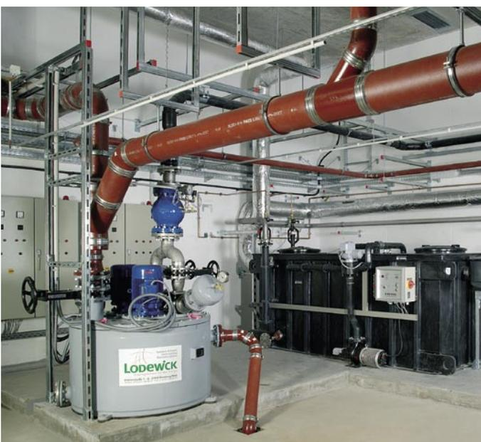
Das anfallende Regenwasser von der umlaufenden Rinne und den Freiflächen wird über Schlammfänge geführt und über Hebeanlagen entwässert
