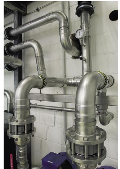
Bild 2 Mit der „Sanpress Inox“-Rohrdimension 64 mm ist eine bedarfsgerechtere Auslegung der Trinkwassernetze möglich, da sonst die nächst größere Dimension von 76,1 mm zum Einsatz kommt
