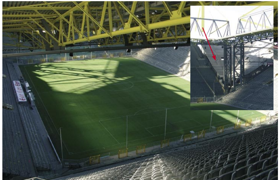
Bild 1 Die alte Dachkonstruktion ruhte auf Säulen, die sich am Ende der Tribünenendächer befanden. Die Entwässerung der Stadionsdächer erfolgte über innenliegende Rinnen. An den Stützkonstruktionen der Giebelseiten wurden die Regenwasser-Falleitungen in das Grundleitungssystem geführt. Durch den Ausbau der Stadionecken wurden die innenliegenden Pylonen durch eine außenliegende Stahlkonstruktion ersetzt. Die Regenwasserabführung musste neu geregelt werden.
