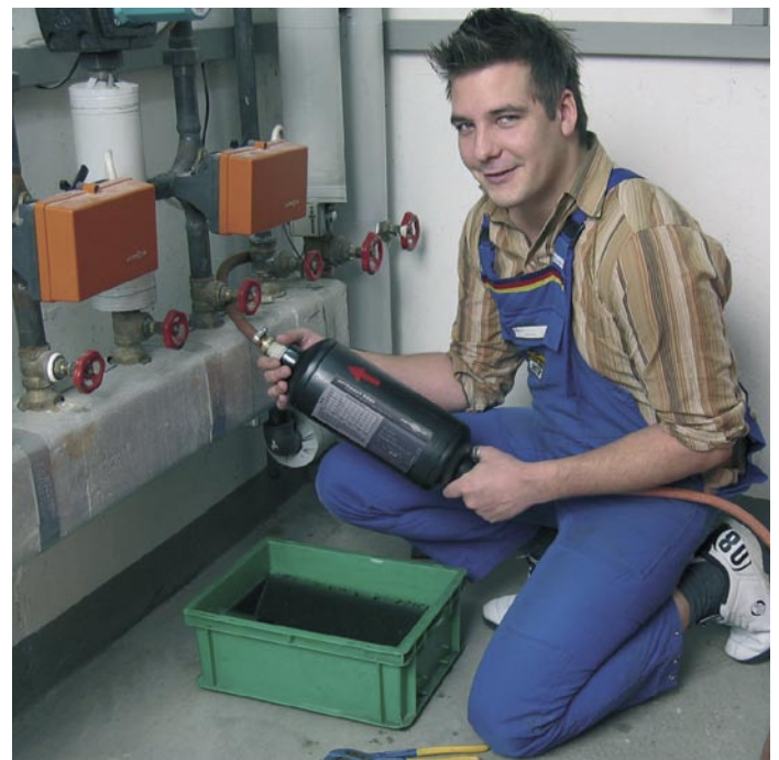
Bild 6 Der Permasoft 5000 entsalzt und alkalisiert Heizungsfüllwasser in einem Schritt
