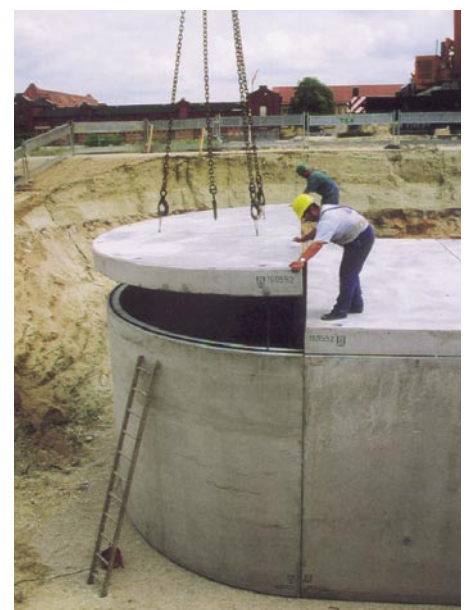
Versetzen des Feuerlöschbehälters aus Betonfertigteilen, Montage der Abdeckplatten
