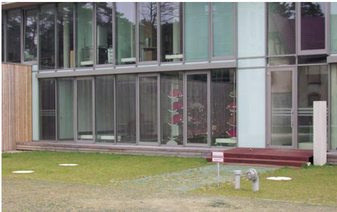
Fassade des FTZ Beelitz, mit Hinweisschild, Saugrohr DN 125 und Lüftungsrohr DN 100
