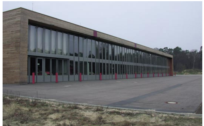
Zufahrt der Einsatzfahrzeuge des FTZ Beelitz
