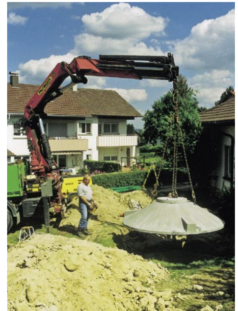
Vom Hersteller mit eigenem Fahrzeugkran in die vorbereitete Baugrube versetzt: Behälter aus einem Guss und Abdeckung als verschraubbares Betonfertigteil mit vorgefertigten Rohranschlüssen
