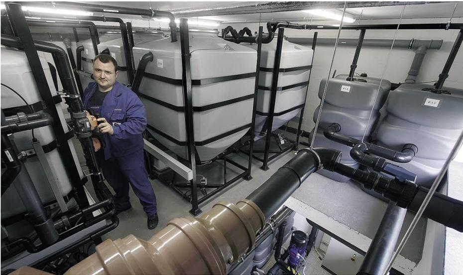
Größere Teilchen wie Textilflusen und Haare werden über einen rückspülbaren Filter ausgesiebt. Die Rückstände gehen in die Kanalisation. Biokulturen bauen in den Recyclekammern die Schmutzanteile des Wassers ab. In Drei-Stunden-Intervallen wird das Wasser weitergepumpt
