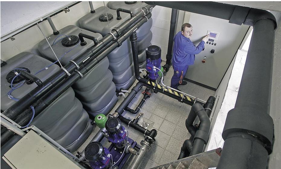
Bevor das Wasser in den Klarwasserspeicher gelangt, umströmt es eine UV-Lampe und wird entkeimt. Danach ist es geruchsfrei und bis zur Wiederverwendung speicherfähig
