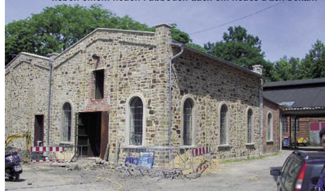
Der alte Pferdestall wurde komplett entkernt (oben), bevor er neben einem neuen Fußboden auch ein neues Dach bekam
