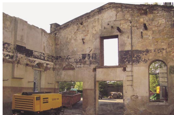
Der alte Pferdestall wurde komplett entkernt (oben), bevor er neben einem neuen Fußboden auch ein neues Dach bekam
