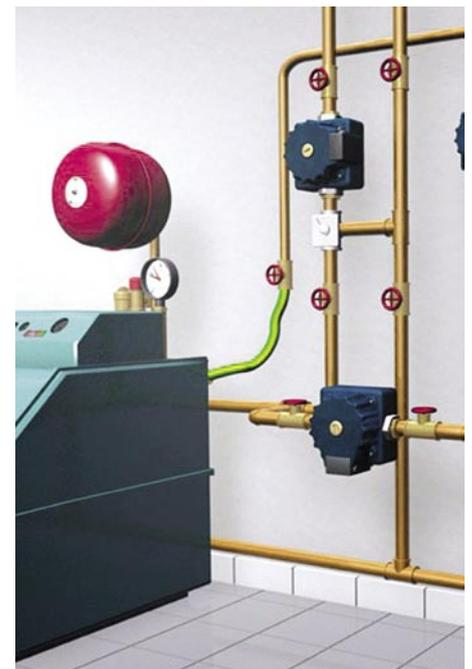
**Bild 2** Die Nachspeisung über einen Schlauch entspricht nicht der DIN EN 1717
