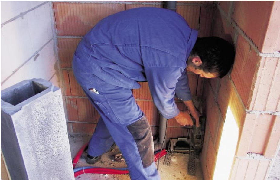
Der Deckendurchbruch wird für die Aufnahme des Skobifixs-30-Systems vorbereitet. Die auflagernden Schächte haben eine Grundfläche von nur 150 mm x 200 mm
