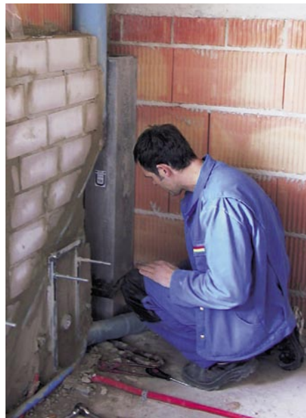
Im Dachgeschoss ist der Schacht in die Vorwandinstallation integriert. Zusätzliche Ecken, Nischen und Kanten bleiben dem Bauherrn dadurch erspart
