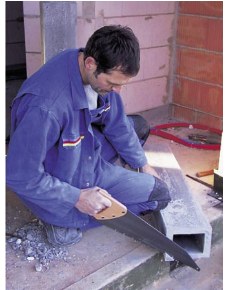
Die Bearbeitung der Schaumkeramik-Elemente erfolgt mit einer grobzahnigen Säge
