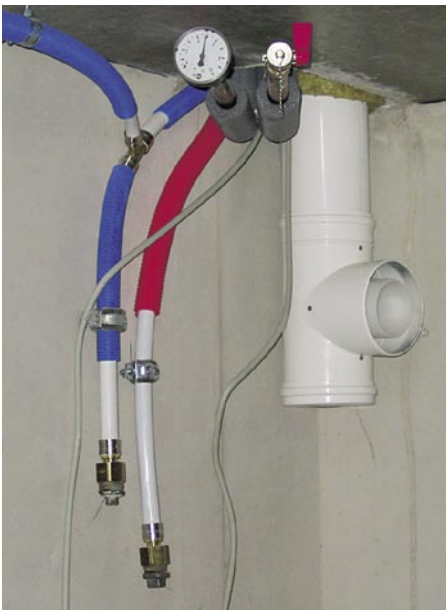
Das patentierte Deckenanschlusselement ist der brandschutztechnische Übergang vom Keller zum EG. Der Schornsteinfeger überprüft von dort aus die senkrechte Abgasleitung
