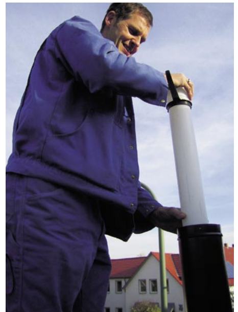
Ist der Schacht erstellt, wird – wie in der Sanierung – PPs-Rohr zusammengesteckt und hinabgelassen. Die Zentrierung übernehmen Spezial-Abstandhalter. Damit ist eine Längsbeweglichkeit und Demontierbarkeit sichergestellt
