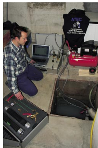
Frank Bergzog arbeitet in NRW als erster im „Fachbetrieb für die Dichtheitsprüfung von Grundstücksentwässerungsanlagen außerhalb und unterhalb von Gebäuden“
