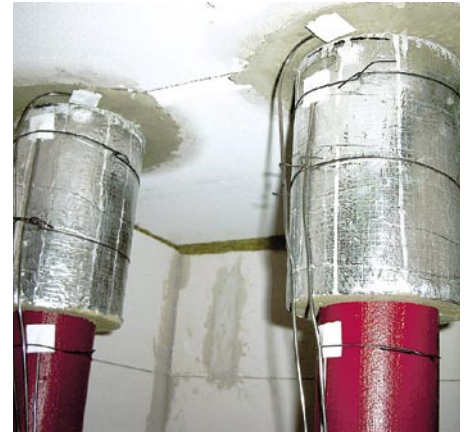
Bild 5: Ansicht Rohre mit Deckendurchführung Untergeschoss vor Versuchsbeginn
