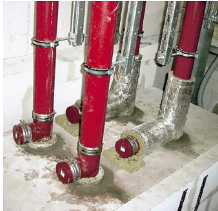
Bild 4: Ansicht Rohre Brandraum vor Versuchsbeginn
