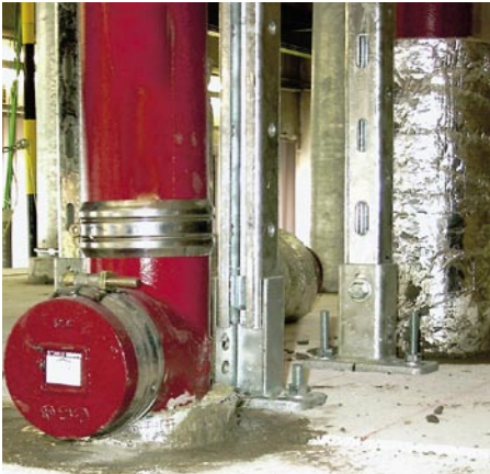
Bild 3: Ansicht Obergeschoss vor Versuchsbeginn
