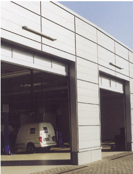
Die Toröffnungen der mit Paneel-Kassetten bekleideten Fassaden wurden sorgfältig integriert
