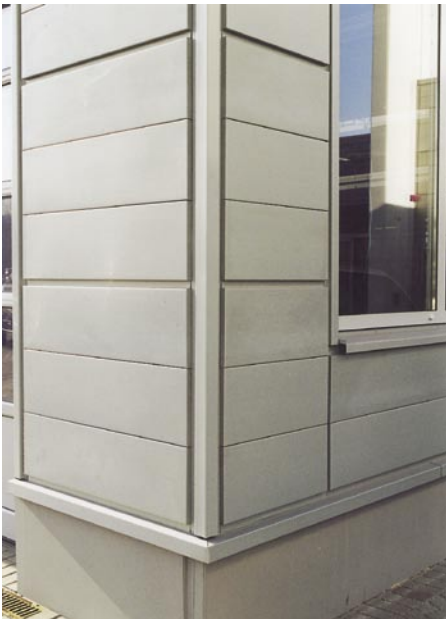
Aus der Nähe gesehen: das „maßgeschneiderte“ Eckdetail mit exakten Schattenfugen und Sockelabschluss ...
