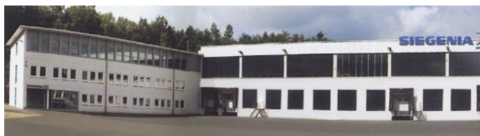
Neues Firmengebäude der Siegenia-Aubi KG im Industriegebiet Lehnscheid
