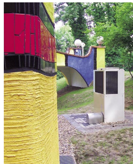
Diese Aisin-Gaswärmepumpe wurde vor dem Hundertwasserhaus in Essen montiert
