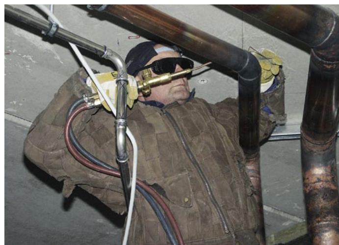
Die Kalt- und Warmwasserversorgungsleitungen aus Kupfer wurden überwiegend geschweißt
