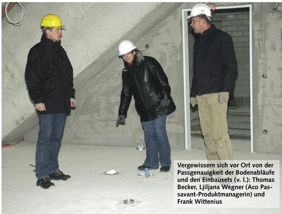
Das Trockenbauelement hängt als Einzelbauteil in einer vorgegebenen Kernbohrung, wobei die Innenkontur des Einbausets auf die jeweilige Außenkontur des Ablaufes abgestimmt ist
