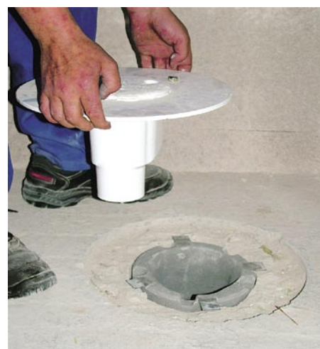
Sofort nach Einbau des Einbausets kann der passende Bodenablauf eingesetzt und die Entwässerungsleitung angeschlossen werden
