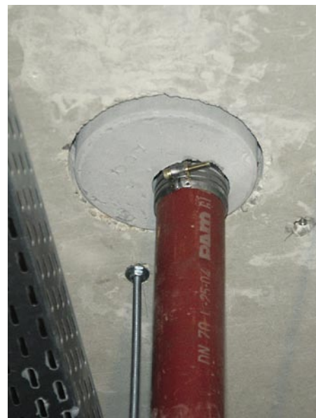
Das Trockenbauelement hängt als Einzelbauteil in einer vorgegebenen Kernbohrung, wobei die Innenkontur des Einbausets auf die jeweilige Außenkontur des Ablaufes abgestimmt ist
