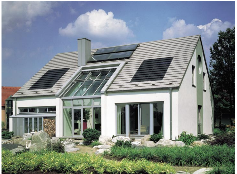
Solarthermie und Photovoltaik sind hier in optisch ansprechender Eintracht auf einem Dach vereint. Die Märkte entwickeln sich allerdings unterschiedlich
