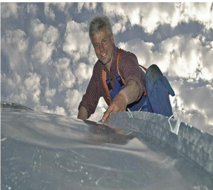
Der Klempner- und Dachdeckerbetrieb Heiner Polenz aus Bergen fertigte das Titanzinkdach des Leuchtturms in Stehfalztechnik
