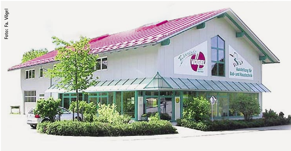
Bild 3 Der Eingang beim SHK-Betrieb Vögel wurde schräg platziert. Im Feng Shui ist dies eine Möglichkeit, um die Energie der wichtigsten Himmelsrichtung zu nutzen
