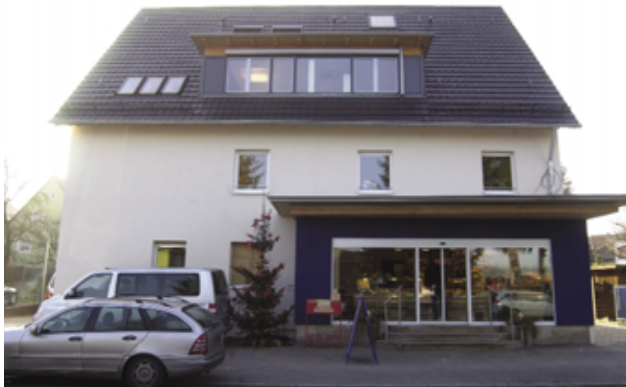
Die Bäckerei war bis auf den ersten Stock niedrigerissen und ab da wieder aufgebaut worden
