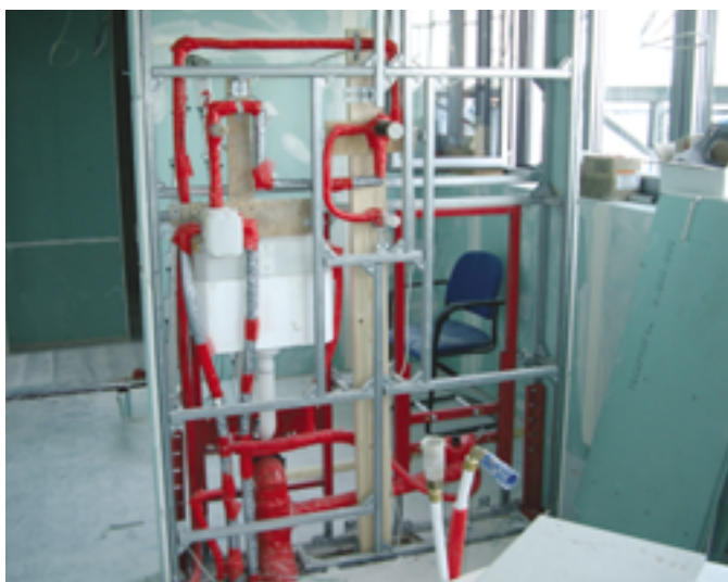
Was jetzt hinter Fliesen verborgen liegt, war in der Rohbauphase deutlich sichtbar: Tece-Haustechnik
