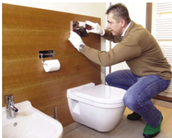
Michael Hilpert demonstriert, wie die WC-Armatur am Spülkasten befestigt, ausgerichtet und arretiert wird
