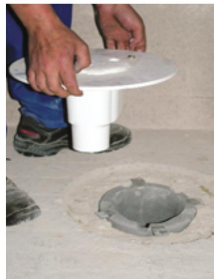
**Bild 4** Aco-Fit-In-Einbauset in Aussparung eingesetzt
