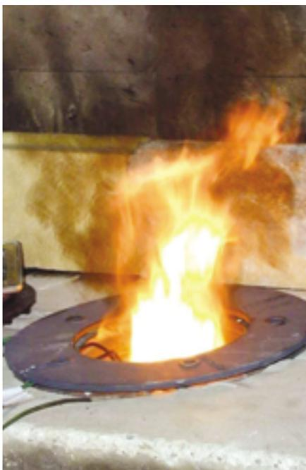
**Bild 1** Feuer und Rauch treten aus dem Bodenablauf aus
