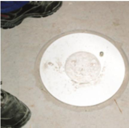
**Bild 5 Brandschutz-Bodenablauf in Fit-In-Einbauset eingesetzt**
