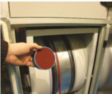
Das Interesse an Desiccant-Cooling scheint wieder zu wachsen. Unter der Bezeichnung POPcool – Power Optimized Process for Cooling – stellte Munters ein Klimagerät mit Sorptionsentfeuchtung, Hochleistungswärmerückgewinnung und Abluftbefeuchtung aus
