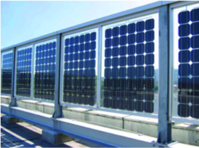
PV-Module mit bifacialer (doppelseitiger) Zelltechnologie können z. B. in freistehenden Brüstungen höhere Erträge erzielen als einseitige PV-Systeme
