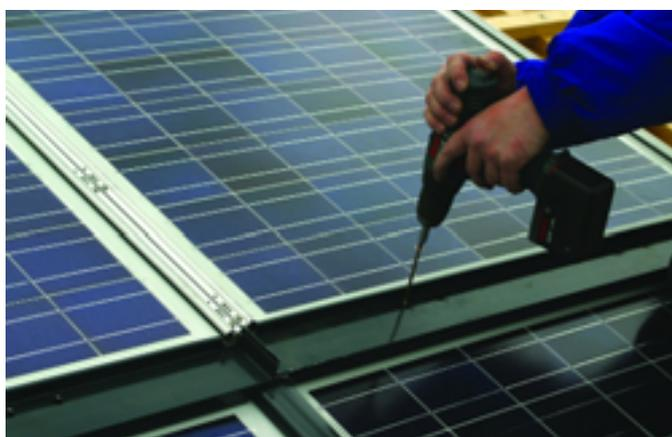
**Montageablauf 3:** Befestigung der OnTop-Module traufseitig mit langen Spax-Schrauben auf der Zusatzlatte; die Schraublöcher werden mit Gummikappen verschlossen
