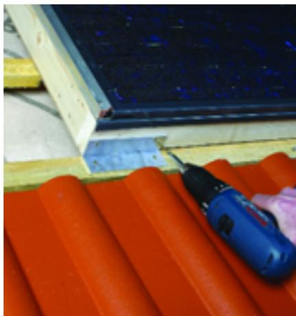
**Montageablauf 2:** Die Module werden trauf- und firstseitig mit Alu-Winkeln auf der Zusatzlatte angeschraubt
