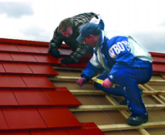
**Montageablauf 1:** Der linke Rand des Modulfeldes wird abgeschnürt. Der Schnurschlag soll parallel zu den Kanten der Dachpfannen sein
