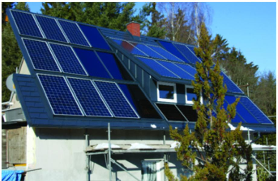
Ästhetisch anspruchsvoll und aus einem Guss: kombinierte Anlage mit PV-Modulen (InDaX-250) und Thermokollektoren
