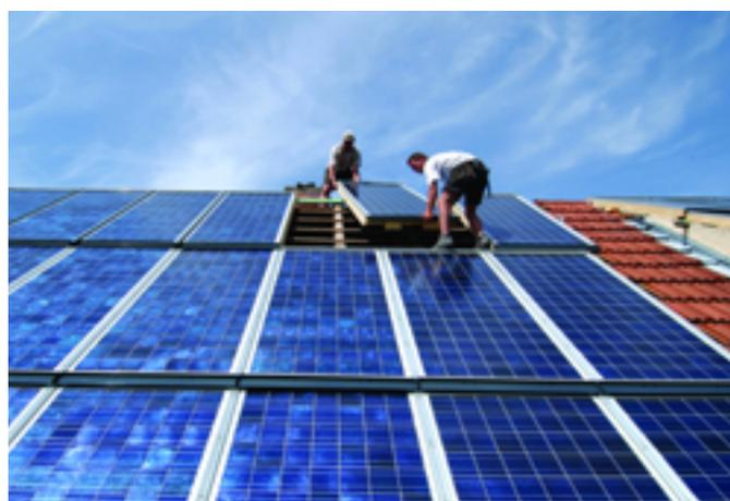
**Montageablauf 4:** Die Module werden von unten nach oben verlegt; hier werden die letzten Module positioniert
