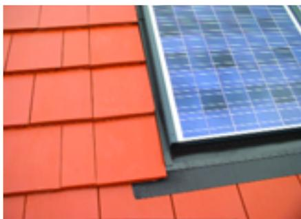
**Montageablauf 6:** Die Module werden von links nach rechts verlegt, so dass am linken Anschluss die Dachpfannen nicht geschnitten werden müssen; dies erfolgt bei Bedarf am rechten Anschluss
