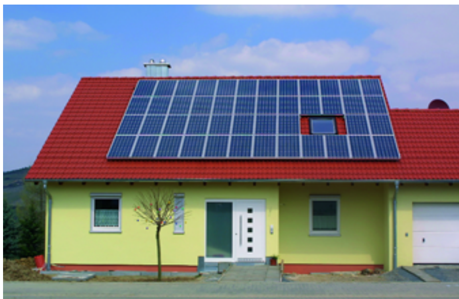
Foto: Sharp Solar, Hamburg (www.sharp-solar.de)
