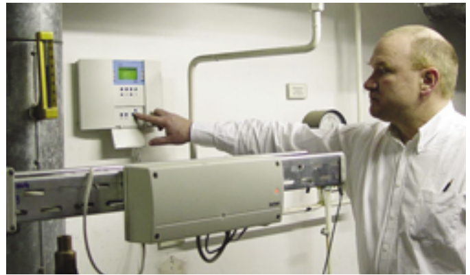
Für das funkbasierte Hausautomationssystem Assisto gibt's jetzt eine bedarfsgeführte Vorlauftemperaturregelung für Mehrfamilienhäuser
