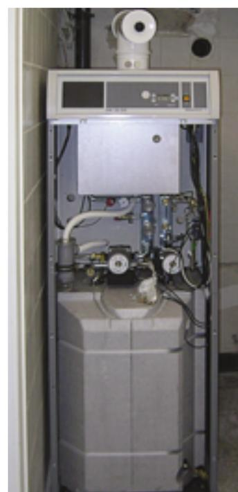
**Die S-Reihe der Gas-Brennwertgeräteserie Econfloor (3,5 bis 15 kW und 7,3 bis 24,7 kW) verfügt über einen werkseitig eingebauten 135-l-Warmwasserspeicher**
