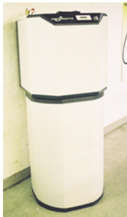
Das Wärmepumpensystem AI-1 (Watterkotte) ist nun in geteilter Ausführung (Wärmepumpe und 250-l-WW-Speicher) lieferbar
