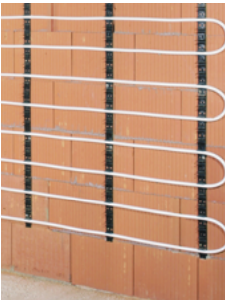
Beim Nassputzsystem der Wandheizung von Kermi wird eine Klemmschiene mit Kleberücken verwendet
