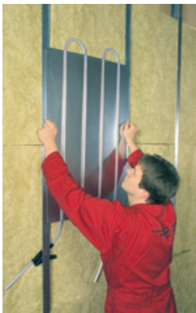
Das neue velta siccus SW Ständerwandelement
