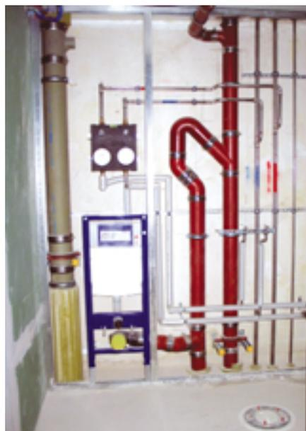
R 90 Schachtinstallationen mit PAM-Global SML Abflussrohren und RML Lüftungsrohren aus Guss
