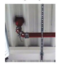
An der Unterseite des INO sorgen PAM-Global-Universalkrallen für bestmögliche Längskraftschlüssigkeit
