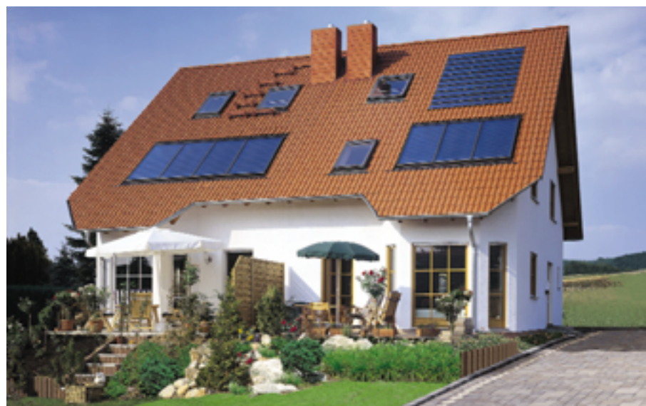
Unbedingt wichtig bei der Aktion „Wärme von der Sonne“ ist die Beteiligung des Handwerks. Denn nur so besteht die Chance, dass Solarthermieanlagen auch realisiert werden
