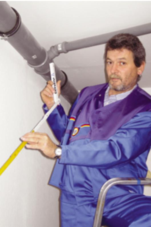
**Bild 5** Rohrleitungen werden nach VOB Teil C einschließlich Rohrbögen bis zum Schnittpunkt der Mittelachse gemessen. Armaturen und Formstücke werden zusätzlich gerechnet
