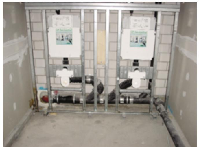
Beim „VariVIT Step WC“-Element mit vormontiertem „Sanicontrol“-Spülkasten kann wegen der verstellbaren Bolzen ein Höhenausgleich auch nach der Verfließung vorgenommen werden
