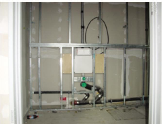
Die beiden Holzplatten zur Anbringung der Stützklappgriffe wurden beim „VariTEC“-Installationselement für barrierefreie WCs werkseitig integriert
