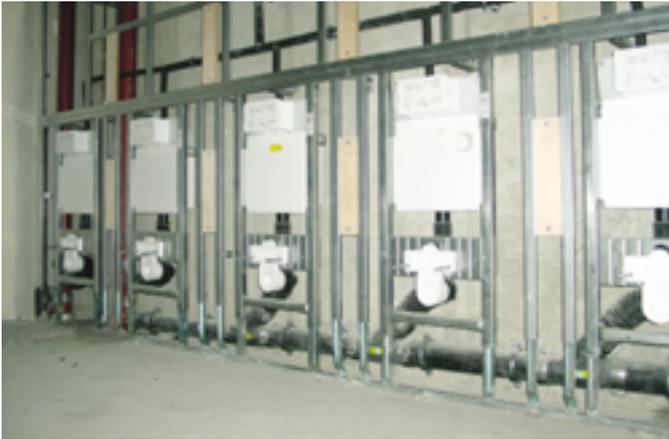
Mepa liefert seine „VariTEC“-Installationswände vorgefertigt in transportfähigen Modulen. Hier ein Trennwandsystem mit fünf „VariVIT Step WC“-Elementen und integrierten Holzleisten in den Grund- und Aufsatzelementen
