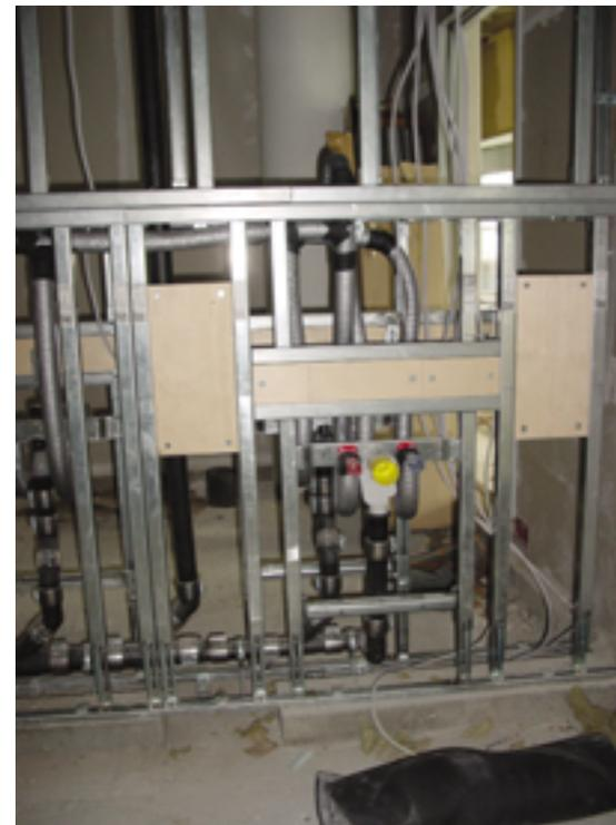
Komplett vorgefertigtes „VariTEC“-Installationselement für barrierefreie Waschtische: Während die werkseitig integrierte waagerechte Holzleiste eine stabile Befestigung größerer Waschtische ermöglicht, dienen die beiden senkrecht integrierten Holzplatten zur Anbringung der Stützklappgriffe
