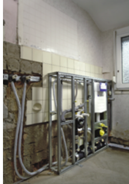
Entscheidend für die kurze Bauzeit war der Einsatz des Installationssystems Geberit GIS
