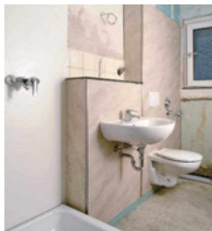
Nach einem Tag war das neue Bad zwar noch nicht fertig, aber Waschbecken und Toilette wieder nutzbar
