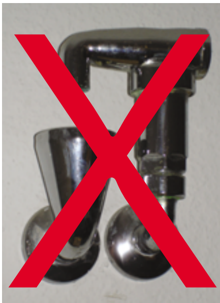
Time to say goodbye: der Rohrbelüfter hat als Sammelsicherung im Wohnungsbau ausgedient
