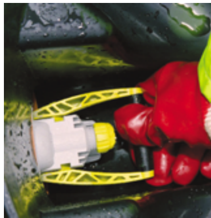
Bild 7 Spannen eines Exzenter-Rohrverschlusses
