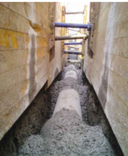
Bild 9 Rohrscheitelbefestigung vor Verfüllung der Baugrube mit Flüssigboden
