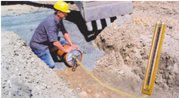
Bild 4 Kanal-Dichtheitsprüfung mit Medium Luft
