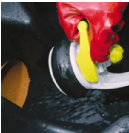
Bild 6 Einsetzen des Rohrverschlusses
