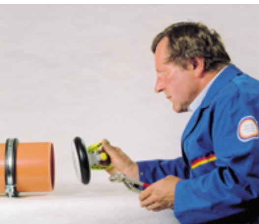
Bild 10 SHK-Installateur beim Setzen des Wasser-Stopps
