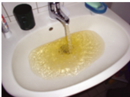
Verfärbtes Wasser durch Korrosionsvorgänge
