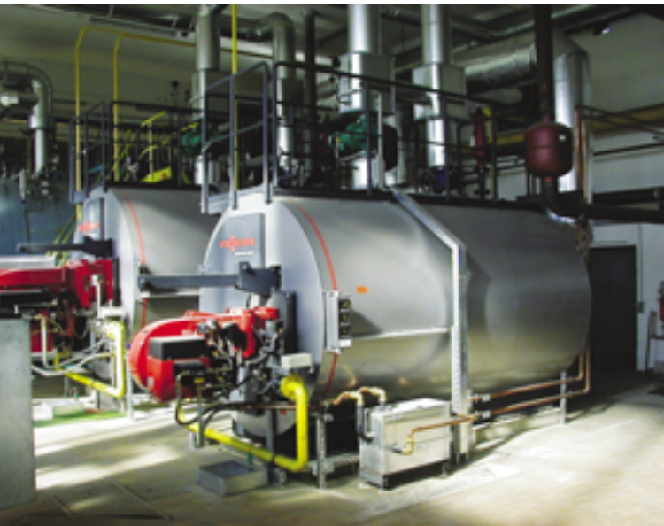
Bild 1 Die Frage nach einer Einkessel- oder Mehrkesselanlage stellt sich insbesondere im größeren Leistungsbereich
