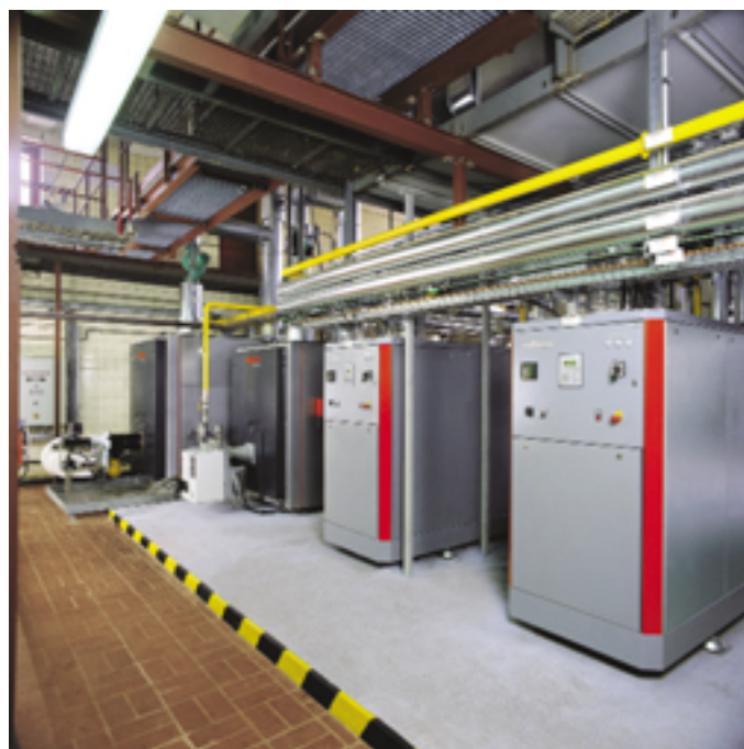
Bild 3 Zwei NT-Heizkessel und zwei BHKWs sorgen im Klinikum Salzgitter-Bad für hohe Betriebssicherheit bei der Wärmeversorgung
