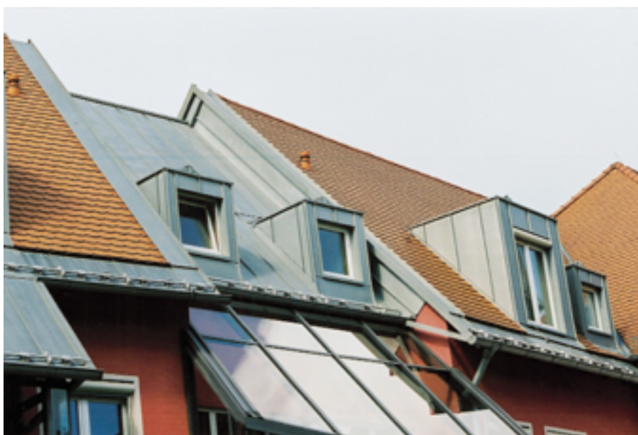
Verschiedene Teilflächen im Dachbereich sowie Ortgänge, Traufen und Giebelversprünge wurden klempnertechnisch in „vorbewittertem“ Rheinzink gedeckt
