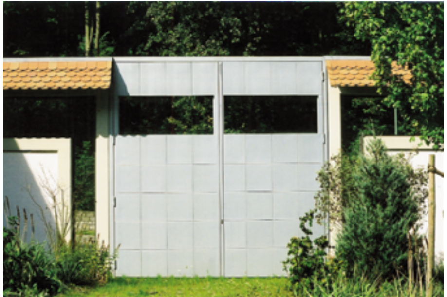
Eine ungewöhnliche Klempnerarbeit ist dieses Hof- oder Gartentor, das in der Werkstatt des Klempner-Fachbetriebes angefertigt wurde
