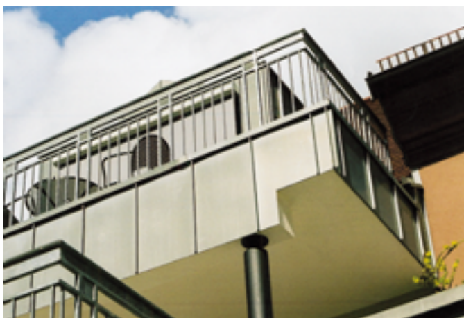
Im Detail ist die gelungene Winkelstehfalzbekleidung des vertikalen Balkonbereiches erkennbar
