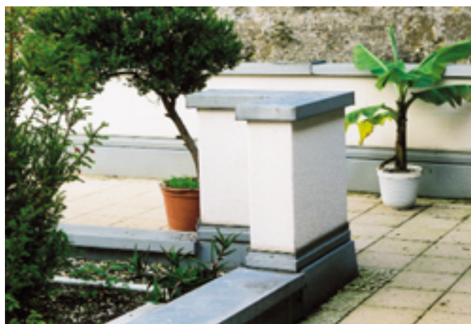
Eine Reihe freistehender Bauteile waren auch im Gartenbereich vor schädigenden Witterungseinflüssen mit metallischen Abdeckungen und Einfassungen zu schützen
