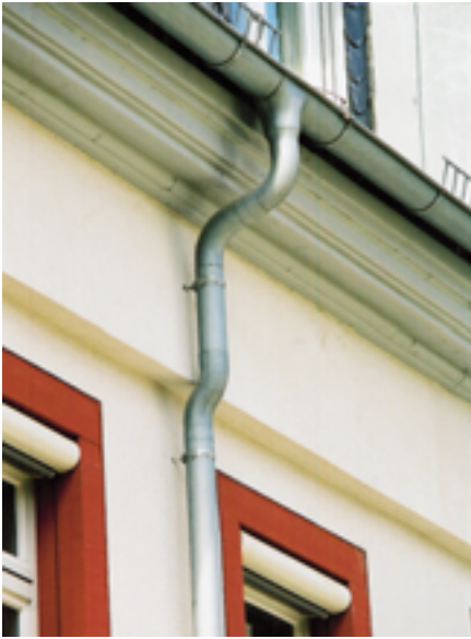
Die Dachentwässerung wurde – passend zu den anderen Metallarbeiten – ebenfalls in „vorbewittertem“ Rheinzink ausgeführt
