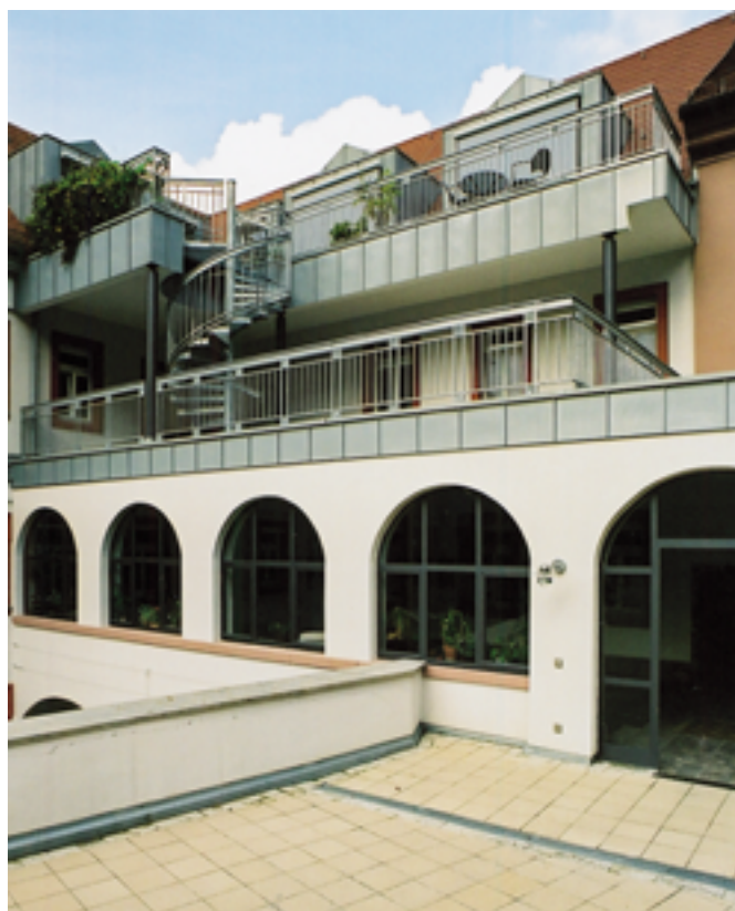
Attikabekleidungen, Balkonbrüstungen und weitere Bauteile sind mit einer Wetterhaut in Metall geschützt und architektonisch gestaltet
