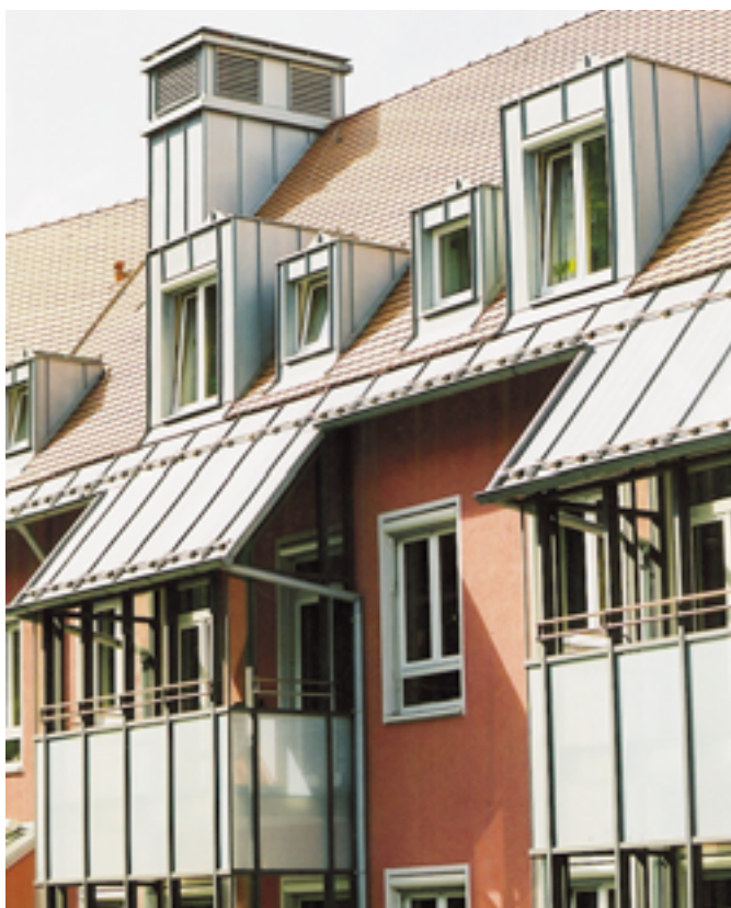
Zahlreiche Gauben, Schornsteinköpfe und Vordächer über den Balkonen wurden in aktueller Falztechnik ausgeführt
