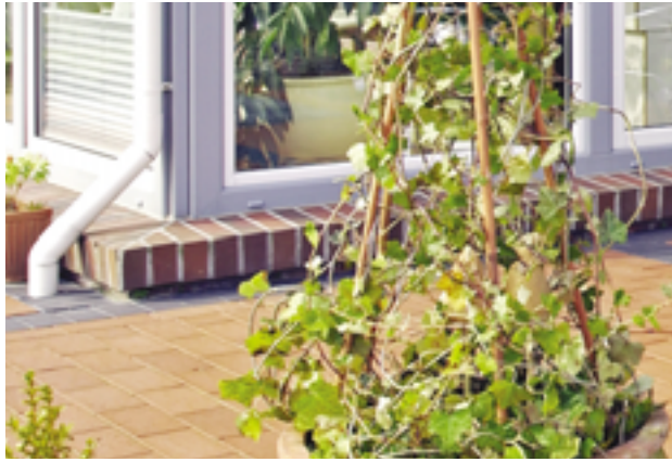
Der Bodenaufbau im Wintergarten wurde erhöht, um für die Fußbodenheizung genügend Speichermasse und damit ein ausgeglicheneres Temperaturbild zu erzielen
