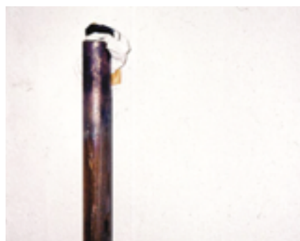
Bild 3 und 4 Rohrendenschutz während der Installation
