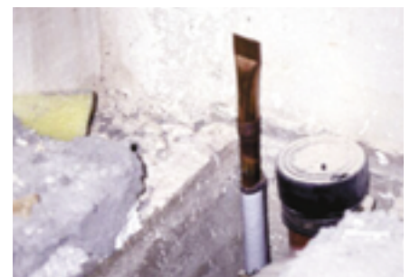
Bild 3 und 4 Rohrendenschutz während der Installation
