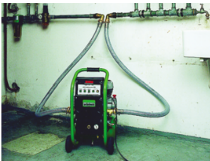
Bild 7 Spülkompressor für das Spülverfahren Luft/Wasser-Gemisch
