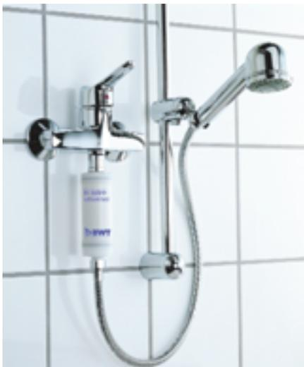
der geringen Porenweite sollen so Legionellen und andere Bakterien zuverlässig abgetrennt werden. Dieser neuartige Hygiene-Filter ist in zwei Einbau-Ausführungen verfügbar: Die Variante B-Safe-universal wird zwischen Mischarmatur und Duschschlauch installiert. Die Variante B-Safe-spezial wird im Wandauslass
