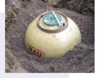
wasserspiegel, selbst im leeren Zustand, ohne Beton auftriebssicher sein. Mit entsprechender Abdeckung sind sie sogar mit dem Pkw befahrbar und können also auch unter Carports oder Wegen eingebaut werden. Die Blue Rain-Kugeln gibt es in sieben Größen von 2000 bis 14 000 Liter Volumen. Das Gewicht einer 4000 Liter-Kugel beträgt beispielsweise 100 kg. Dadurch kann sie mit zwei Mann in die Grube gehoben und durch den Standfuß positioniert werden.
