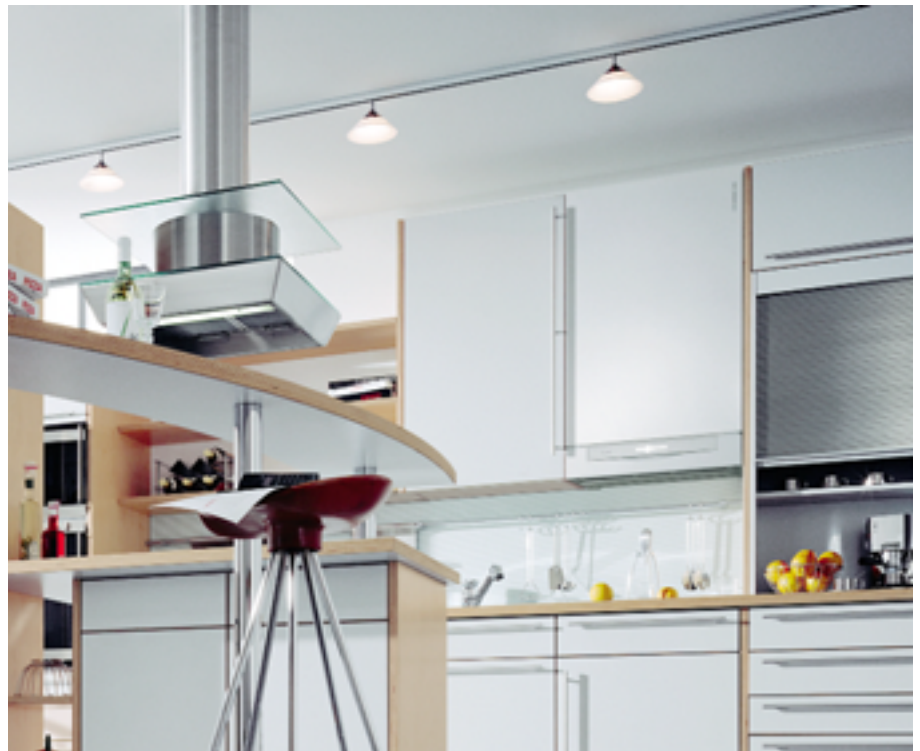
Bild 2 Brennwert-Wandgerät mit Durchlauferhitzer in der Küche
