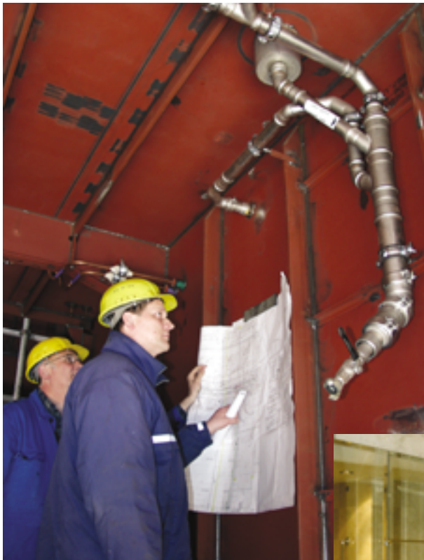
Hans-Albert Schröder (vorne) setzt auf großen Schiffen entwässerungstechnisch auf Unterdruck
