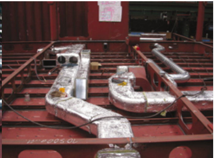
Quasi spiegelverkehrt werden die Installationen an den Decks angebracht...
