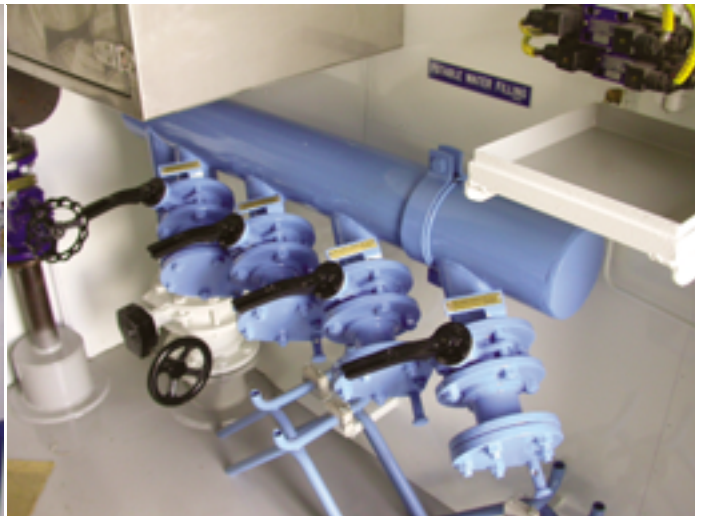
Für die Erstversorgung werden über diese Füllanschlüsse 2875 m 3 Trinkwasser im Hafen gebunkert
