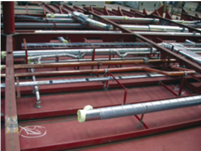
Die Meyer-Werft arbeitet nach einer Art Bausteinprinzip. Dabei werden die Leitungen bereits an den Decks befestigt, aus denen Blocks entstehen
