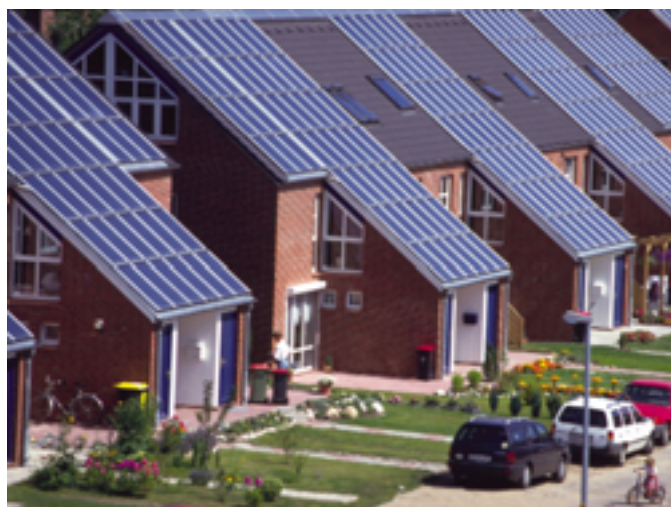
Anfang der 90er Jahre breiteten sich thermische Großanlagen aus; hier die Siedlung Hamburg/Brahmfeld
