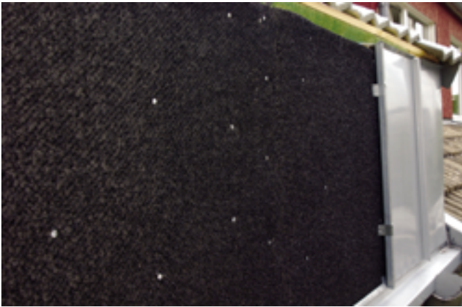
Strukturierte Trennlage unter der Fassadenbekleidung aus Titanzink
