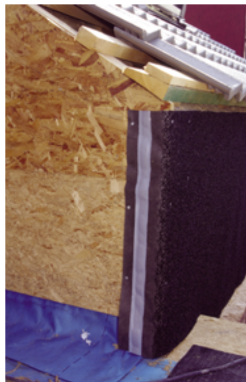
Einsatz der strukturierten Trennlage im Fassadendetailbereich
