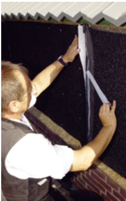
Der Kopfstoß wird geschlossen
