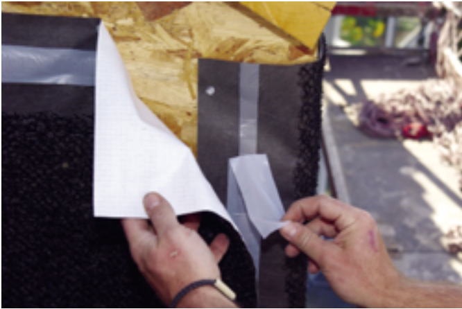
Die Überlappungsbereiche werden durch den integrierten Kleberand geschlossen
